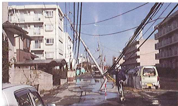
被害を受けた電柱と電線（国土交通省サイトより）
